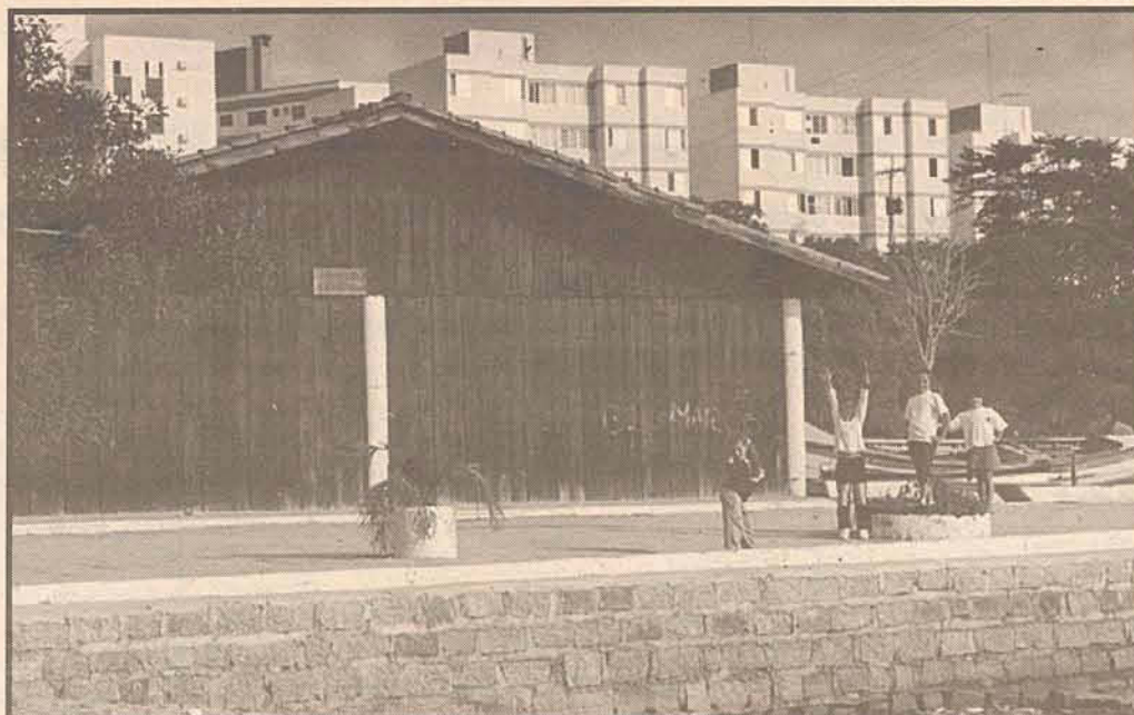
MUTIRÃO: Rancho dos pescadores recebeu muro de contenção e calçamento
