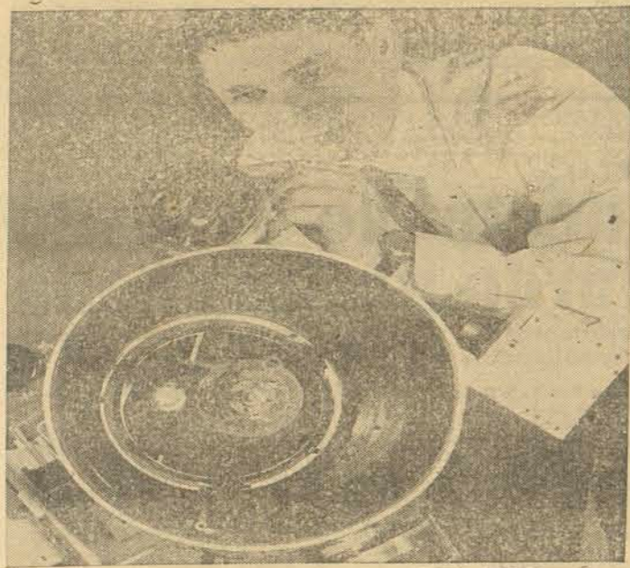
A HUGHES AIRCRAFT CO., de Culver City, Califórnia, aperfeiçoou um novo tipo de radar que usa pela primeira vez um raio de luz ao invés de sinais de micro-ondas para detectar objetos distantes. Devido a seu longo alcance, pequenas dimensões e baixa necessidade de energia, este novo tipo de instrumento tem grande aplicação nas experiências com satélites e sondas espaciais. Na foto, um cientista demonstra o funcionamento do novo radar.
