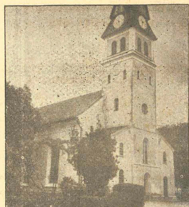
te, que foi também apreciavelmente ampliado. Outras reformas estão programadas, na parte externa, prevendo-se a construção de novas torres.
