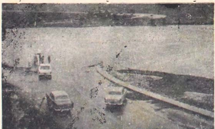
Eis como ficou reduzida a Ponte Eng. Antonio Alves de Noronha, após a avassaladora enchente do último mês de Agosto. A foto acima foi batida, quando as águas já tinham baixado um pouco de sua sanguinária fúria. Dai, poderão os nossos leitores constatar o volume das águas existentes naquele local, parecendo até um mar em realidade.
