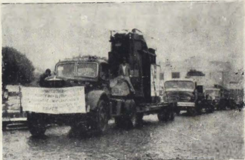
O cliché fixa um dos monumentais transformadores de medida a ser utilizado na Grande Subestação de Lages.
