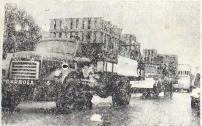
O cliché nos mostra um outro carregamento de materiais, vindo-se vários caminhões, todos eles conduzindo farto material para a Subestação de Lages
