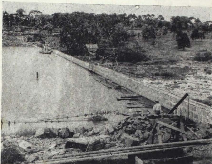
Vista amontante da barragem com o vertedor concluído, estando o nível d'água perto da sua cota final
