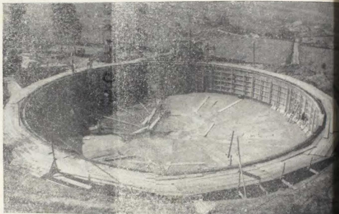
A foto ilustra o novo reservatório d'água, ora em fase de acabamento, com capacidade de 1.520.000 litros, que resolverá em definitivo o problema da água nossa cidade.
