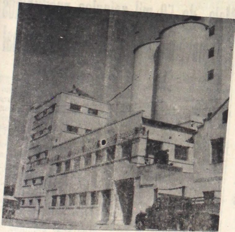
Uma visão lateral do Edifício bem como o silo com capacidade para 50 mil sacos de trigo em grão
