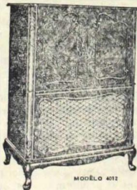
Lindo móvel incorporando o famoso "Tom Sinfônico". Possante rádio de 5 faixas de ondas. 7 válvulas, olho mágico, alto-falante, lâmpada permanente pesada. Troca-discos automático de 3 velocidades, pick-up com 2 agulhas permanentes reversíveis. Ampla discoteca.
