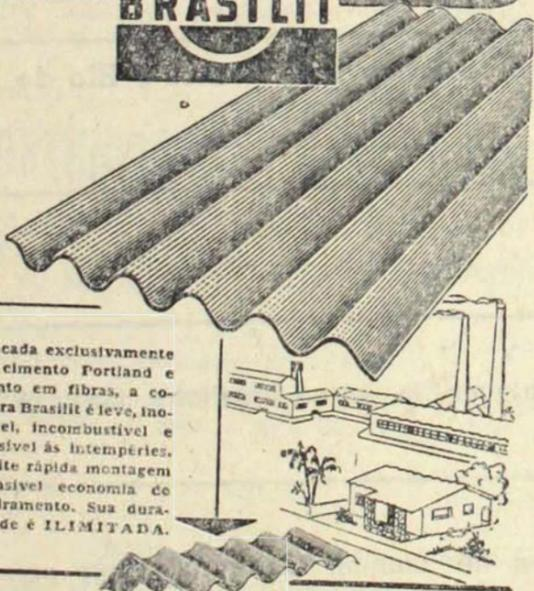
Fabricada exclusivamente com cimento Portland e amianto em fibras, a cobertura Brasilit é leve, inoxidável, incombustível e insensível ás intempéries. Permite rápida montagem e sensível economia de madeframento. Sua durabilidade é ILIMITADA.
