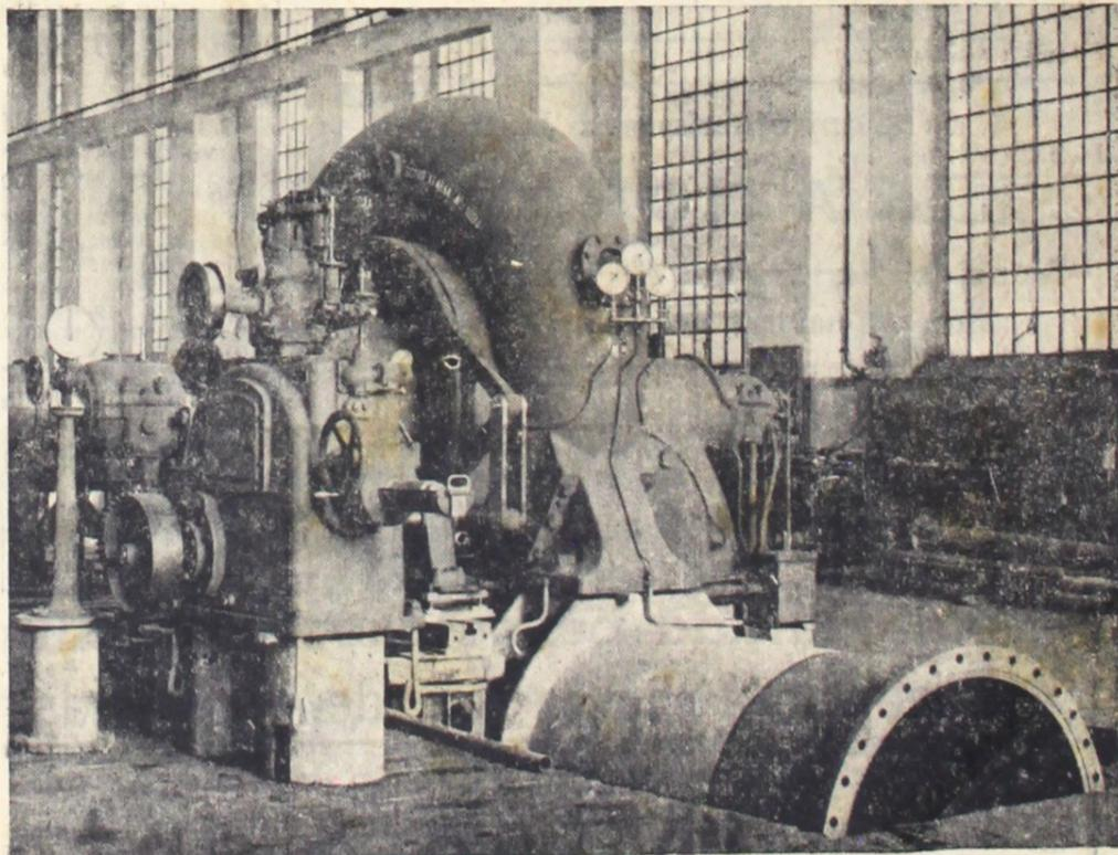
O chichê indica a nova turbina, com 2.115 HP, a ser instalada, brevemente, na usina do Salto.
