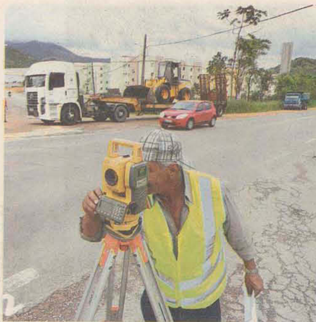
O DNIT anuncia o começo das obras de construção de rotatória em Ribeirão Cavallo, na BR-280. Em frente ao Residencial Dante Minel
