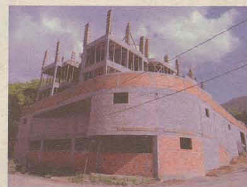
Estágio da obra - foto em 20/11/2013
