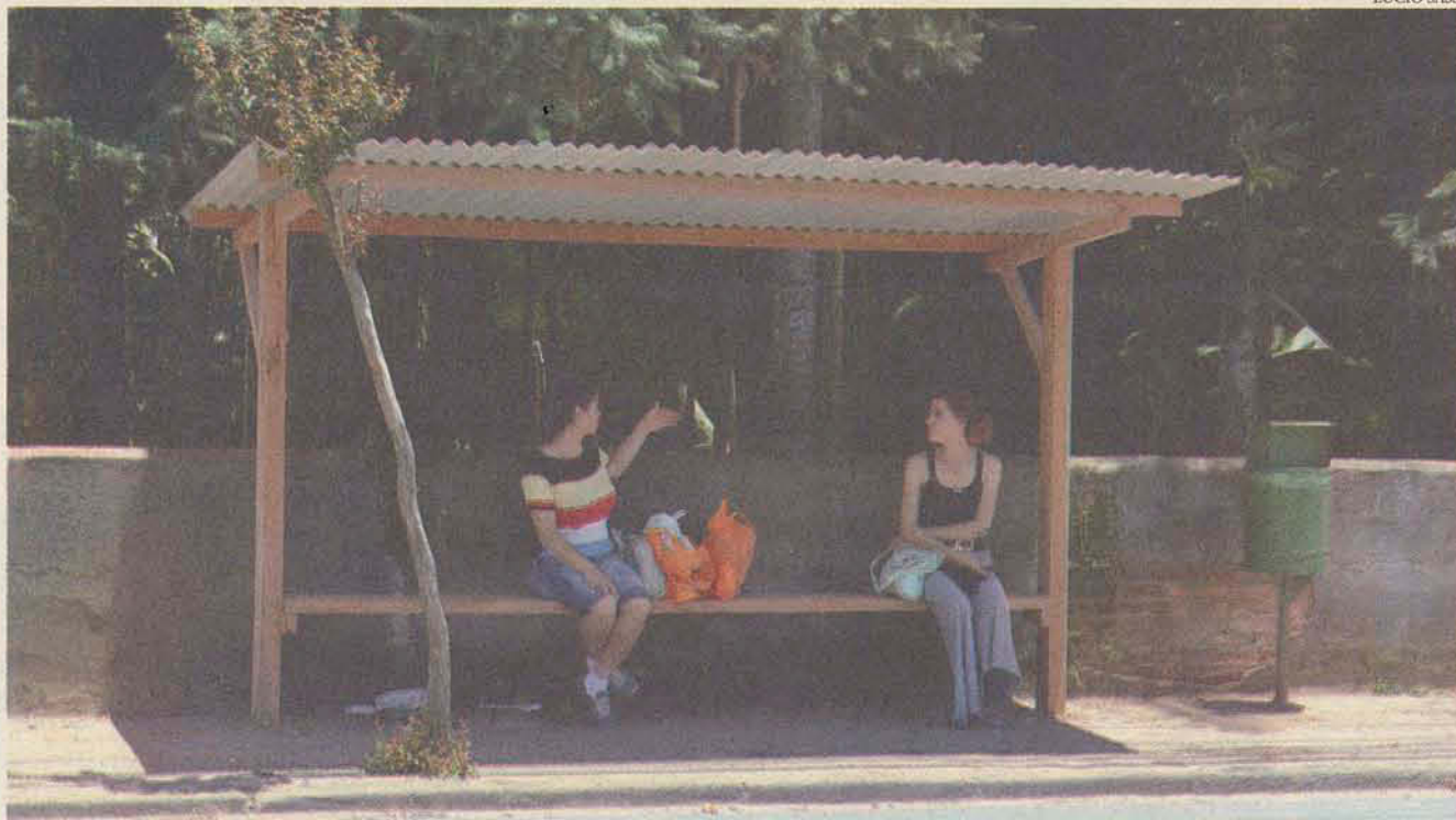
PROVISÓRIO Ponto instalado na Rua Jorge Czerniewicz, próximo ao Pama, é feito com cobertura de amianto
