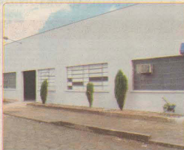
REF. 13007 - Galpão com 225 m 2 .
