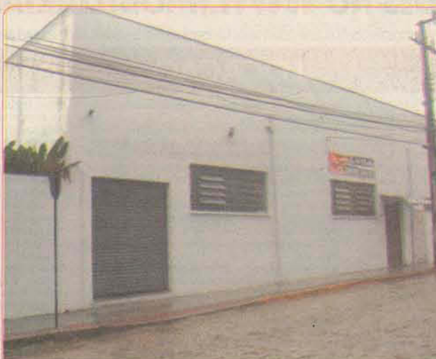
REF. 13006 - Galpão com 272,87 m 2 - 02 banheiros.
