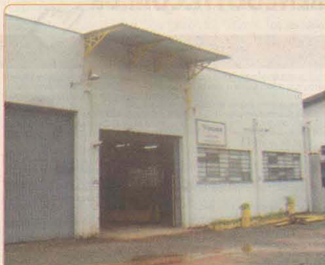
REF. 13005 - Galpão com 686 m 2 - Pé direito com 5 metros - 02 banheiros.
