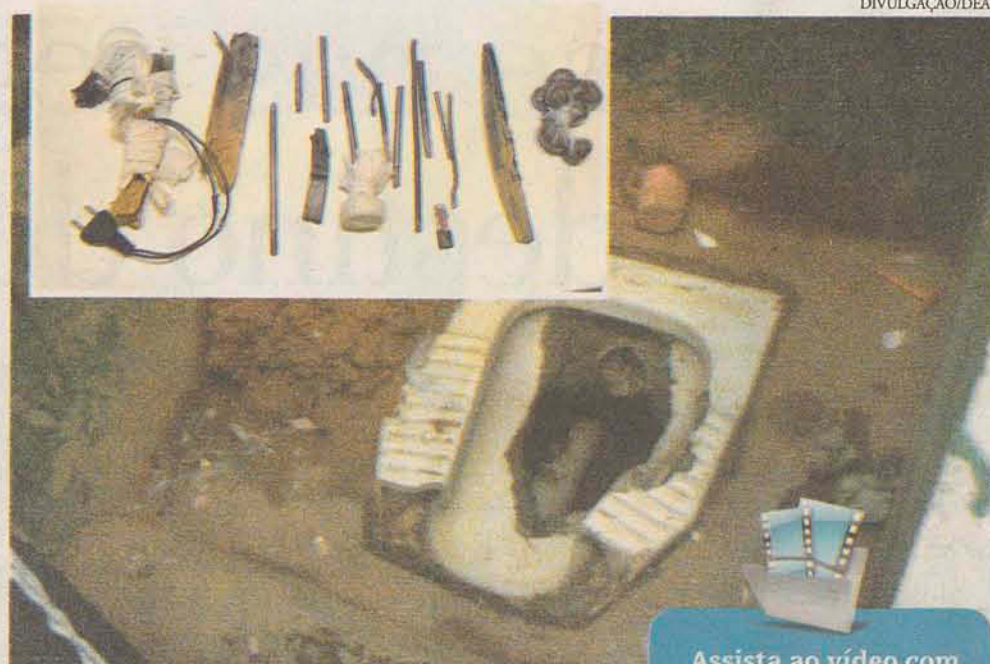
MANUAL Apenados quebraram o vaso e, em dois dias, abriram um canal de 2,5m em direção à cozinha, mas foram flagrados por funcionários
