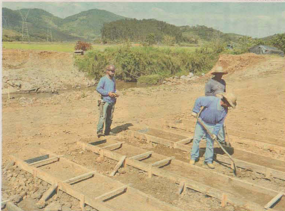
TRABALHO Operários ainda estão na montagem dos moldes das vigas do piso
