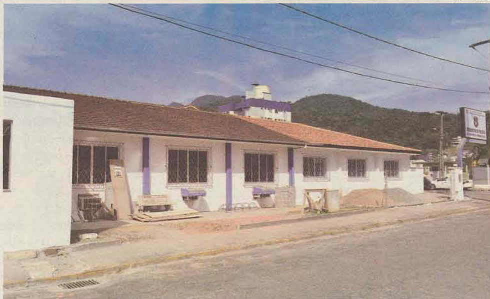
JARAGUÁ O prazo previsto para o término das obras na unidade era agosto
