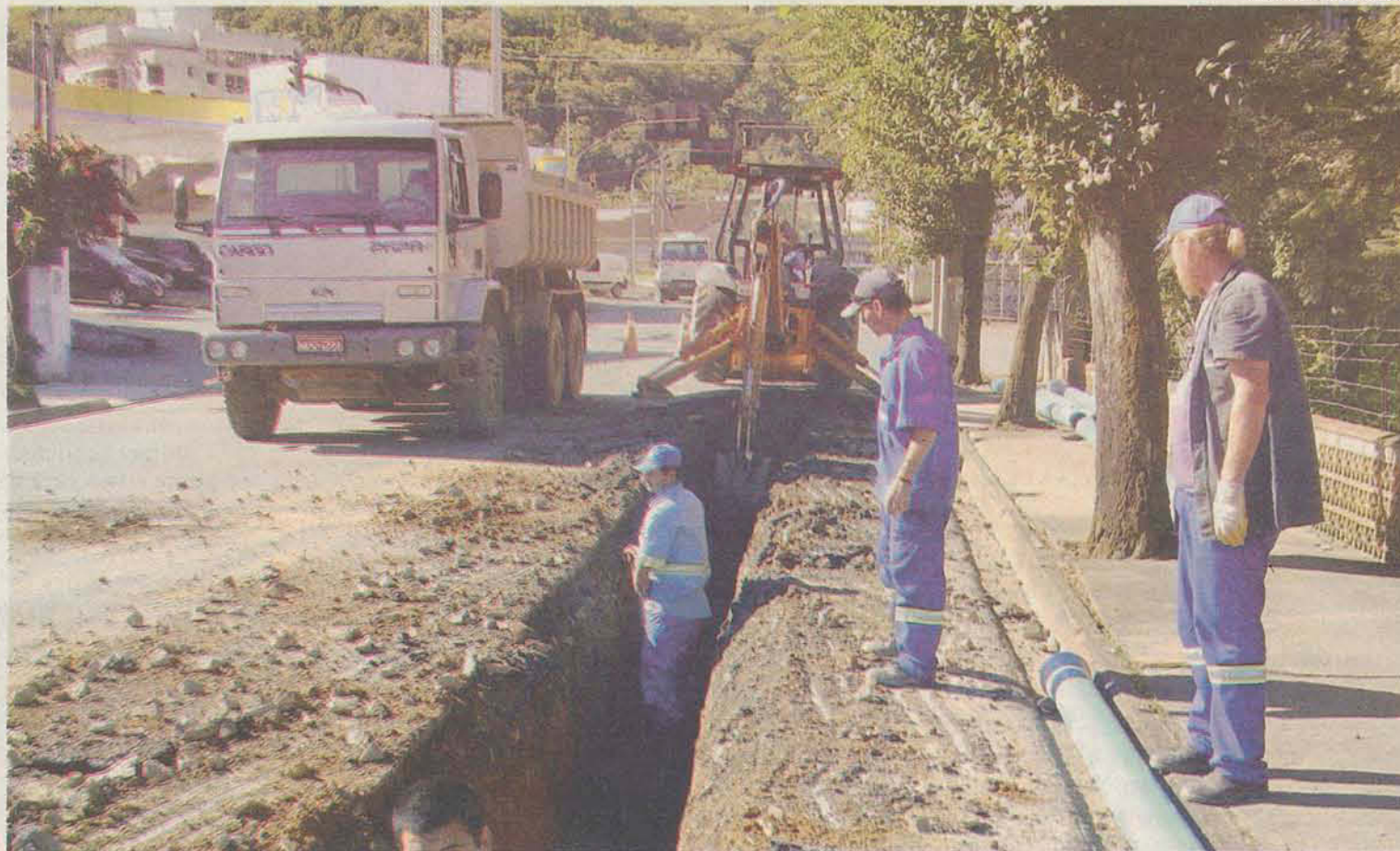
REDE Troca da tubulação de amianto por PVC traz congestionamento, mas garante diminuição de perdas de água
