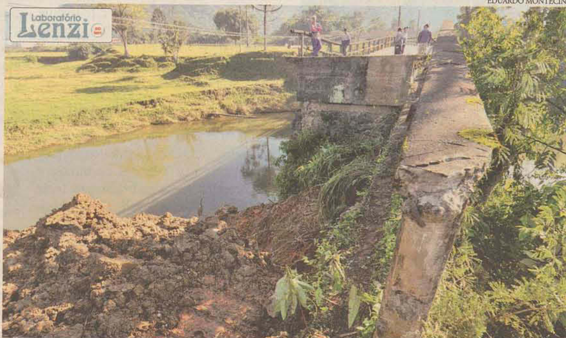
RECUPERAÇÃO Cabeceira que fica no lado de Jaraguá do Sul será reforçada com pedras
