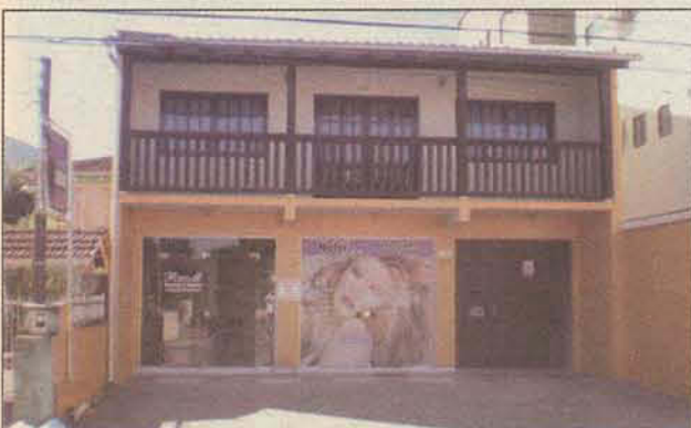
13144 -SOBRADO ALVENARIA C/ SALA COMERCIAL Rua Rio de Janeiro, 193 Czemiewicz - Jaraguá do Sul Área do terreno: 270,00m 2 . - Área construída aprox.: 240,00m 2 . Sendo frente e fundos c/ 9,00m, lado direito e esquerdo c/30,00m.
