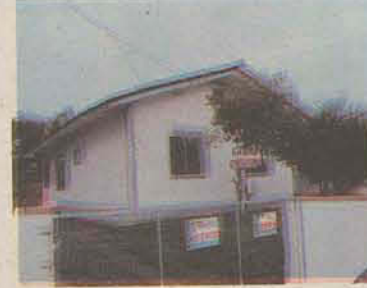
1199: BARRA DO RIO CERRO – CASA ALV. c/ 2 qtos, terreno c/ 367,50m 2 . R$ 200mil
