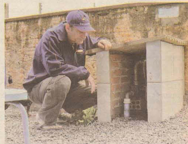
SOLUÇÃO Amarildo puxa a água de um poço artesiano para solucionar a falta de abastecimento
