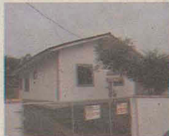
1199: BARRA DO RIO CERRO – CASA ALV. c/ 2 qtos, terreno c/ 367,50m 2 . R$ 200mil
