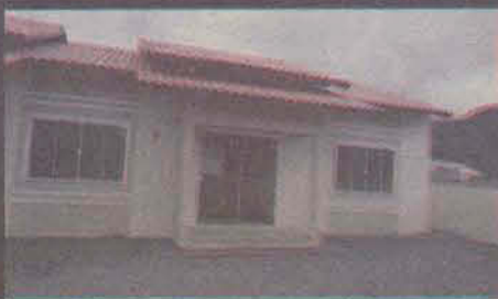
Casa Gemada: Rio Wern / Schroeder. Casa com dois quartos, sala, cozinha, banheiro, lavanderia, vaga de estacionamento e área de festas para uso comum do condomínio. Valor R$ 110.000,00 (financiável)
