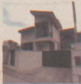
• Ref. 7474 - Guarimirim • Suite + 02 dormitórios • Área imóvel: 342,00m 2 • R$ 500.000,00
