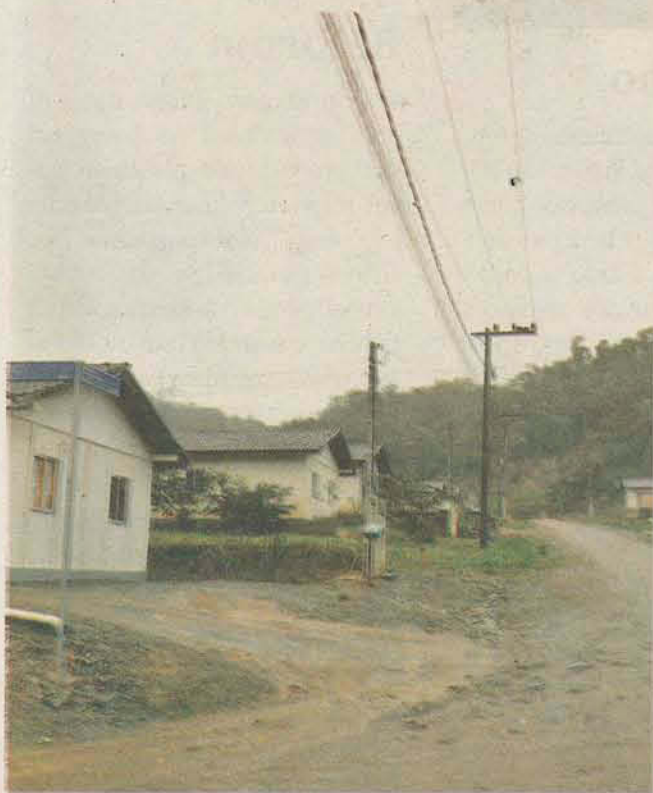
SITUAÇÃO Onze famílias do loteamento Henrique Heise deverão deixar o local por causa dos riscos
