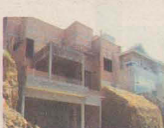
1054: ÁGUA VERDE – CASA ALV. em construção – Casa c/ 245m², terreno c/ 450m². R$ 260mil
