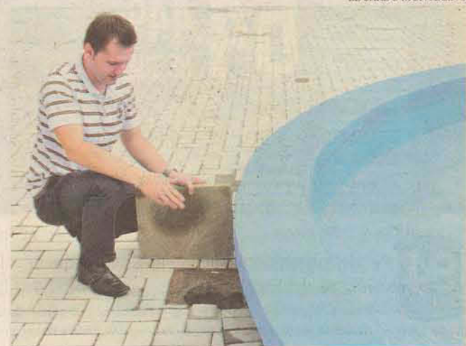
GASTOS Registro do chafariz da praça Helmuth Moritz foi desligado de propósito e acabou queimando
