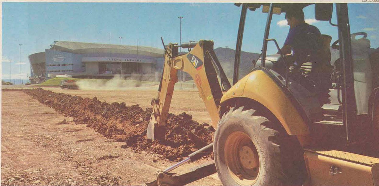
**ILUMINAÇÃO** Máquina abre vala no estacionamento da Arena para colocação da rede elétrica subterrânea dos novos postes
