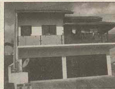
Ref. 219.1 - Sobrado Nova Esperança - Guaramirim Área do Imóvel: 164,42m² Área do terreno: 378,91m² R$ 370.000,00
