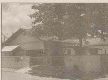
Ref. 17.7 - Casa Amizade - Guaramirim Área do imóvel: 90m² Área do terreno: 391,45m² R$ 170.000,00 Troca por Sítio que tenha nascente de água.
