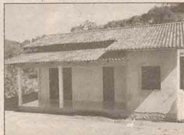
Ref. 181.1 - Casa Bananal do Sul - Guaramirim Área do imóvel: 80m² Área do terreno: 560m² R$ 88.000,00
