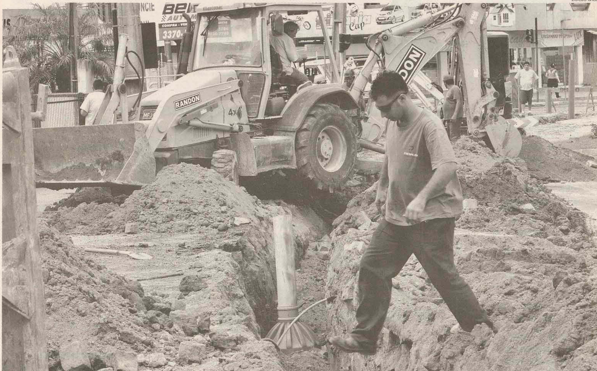
ESGOTO Operários iniciaram ontem a abertura das valas que irão receber a tubulação ligada à estação de tratamento dos dejetos
