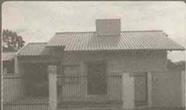
D206- CASA COM 110M² 3 DORMITÓRIOS, SALA DE ESTAR, COPA E COZINHA, BWC, ÁREA DE SERVIÇO E 1 VAGA DE GARAGEM. TERRENO COM 304M². R$195MIL.
