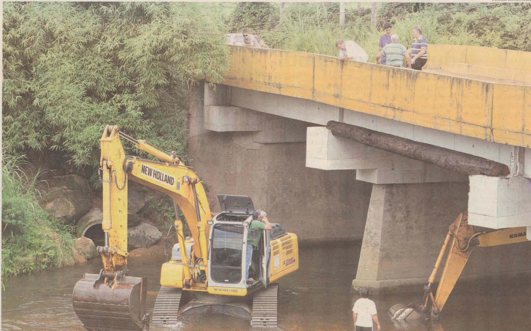
**ALTERNATIVA** Para evitar que ocorra o deslocamento dos pilares foram usados troncos de madeira sobre a base da estrutura
