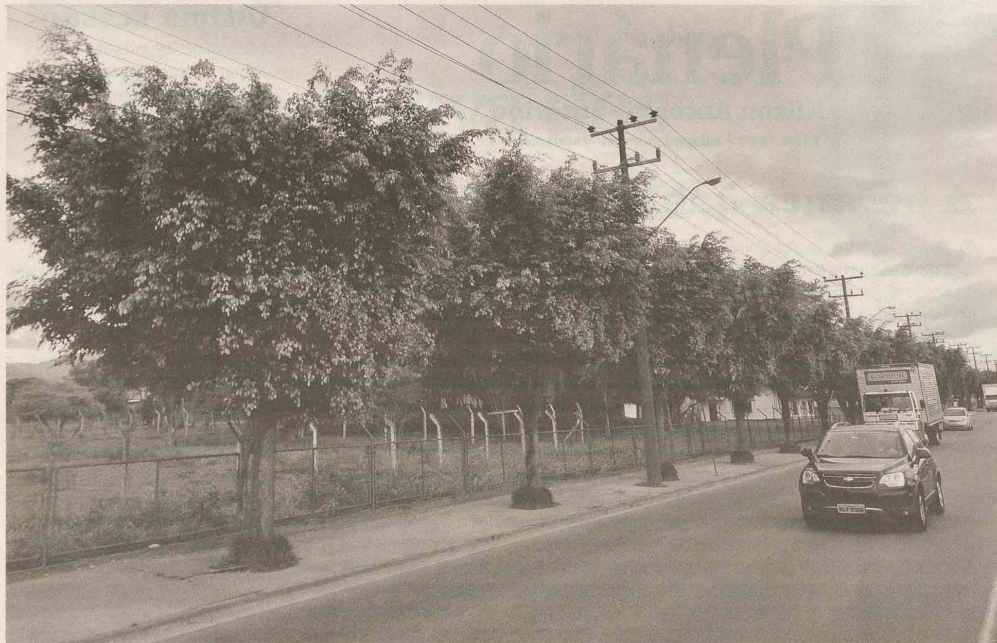
RISCOS Galhos das árvores tomam conta do espaço dos cabos de energia na avenida Waldemar Grubba
