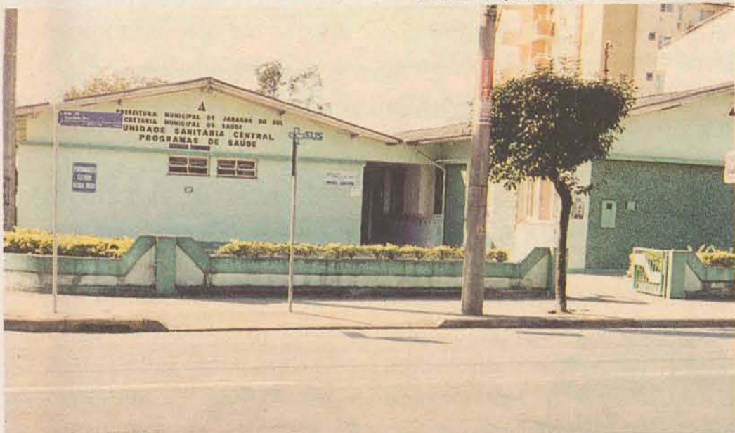
Unidade Sanitária Central, 2004
