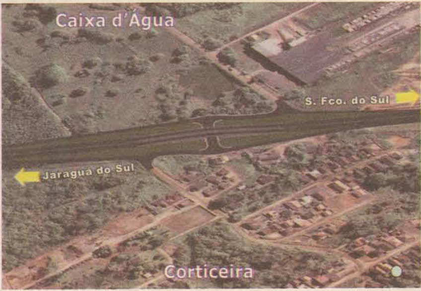
Um elevado para travessia de pedestres deverá ser construído na altura do Km 48,7, em Guaramirim, entre as entradas principais dos bairros da Corticeira e da Caixa d'Água.
