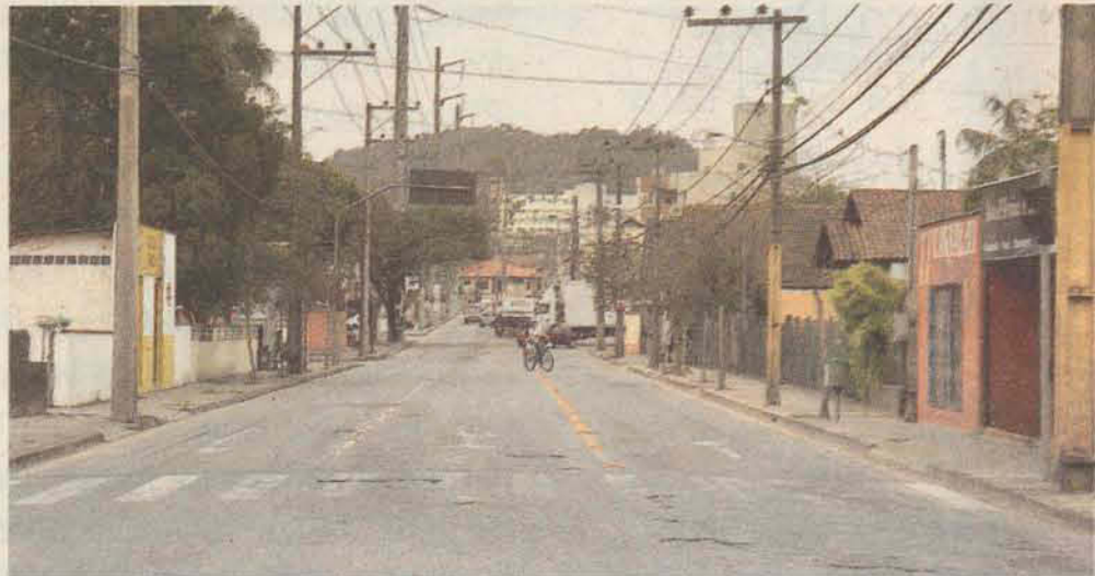
MELHORIAS Trabalhos de pavimentação na Jorge Czerniewicz vão interromper parte da via
