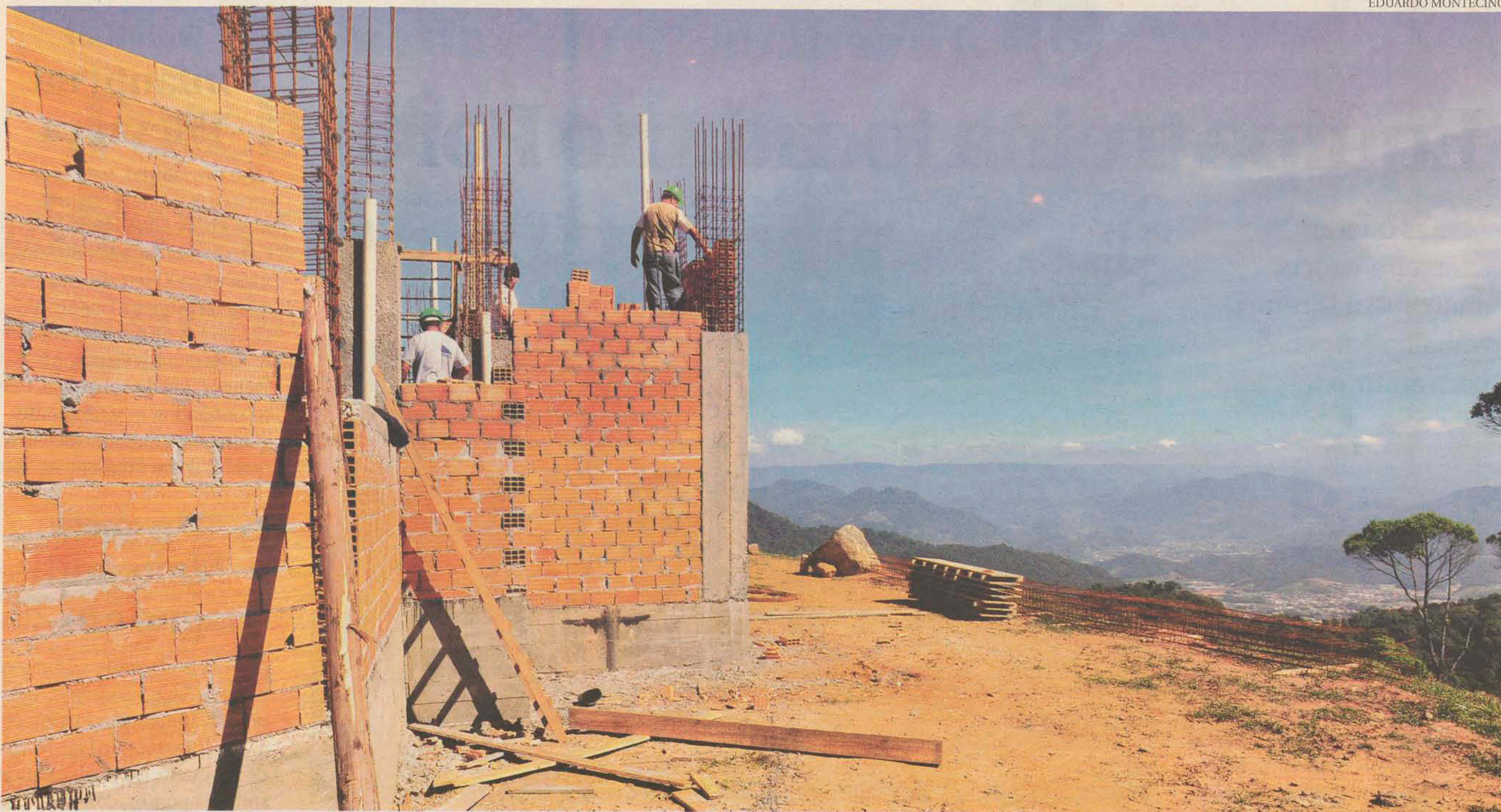
BELA VISTA Operários trabalham na construção da nova igreja, que deve ser inaugurada em novembro, a 600 metros de altura
