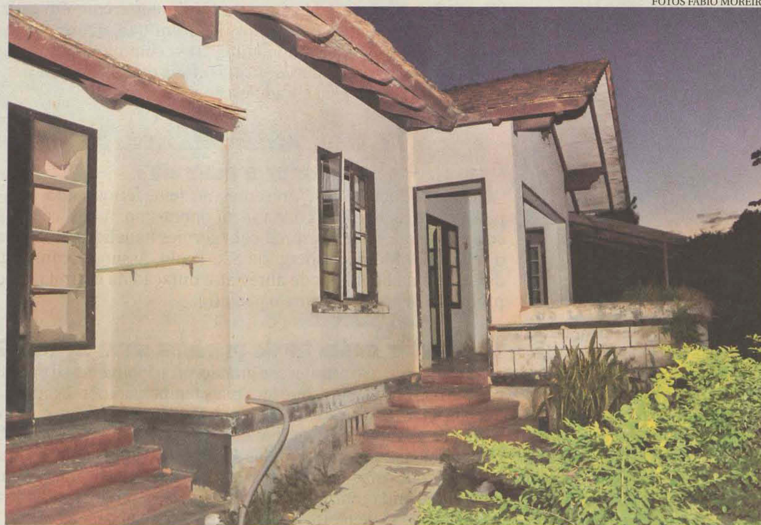
NOVA BRASÍLIA Imóvel foi tombado pelo município no início deste ano
