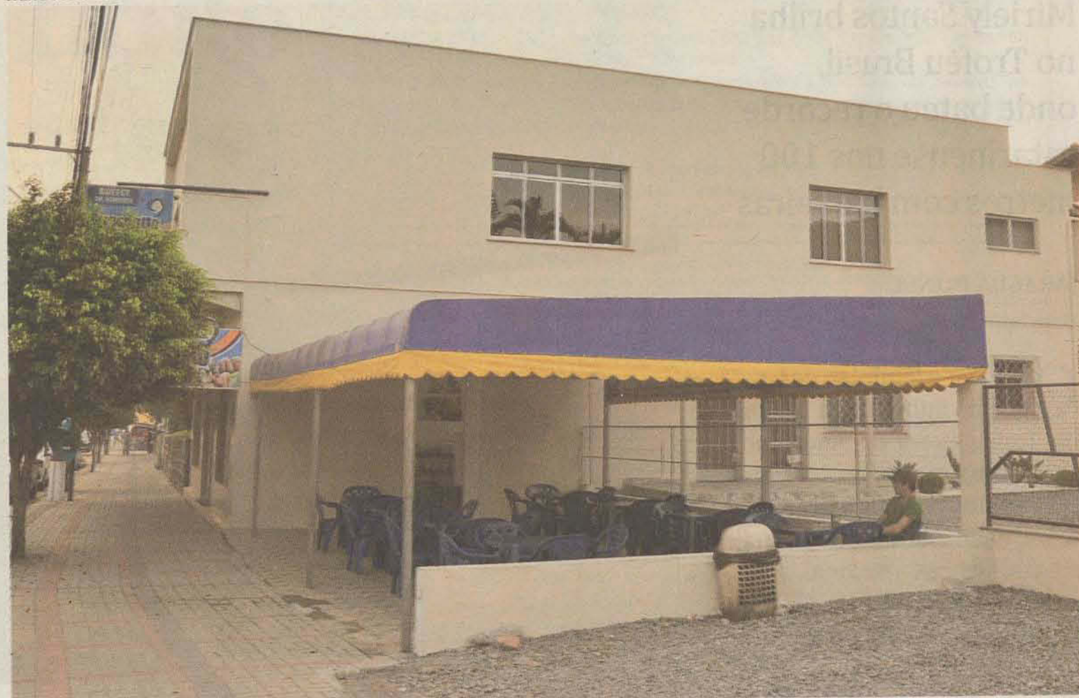
NO CENTRO Imóveis ficam em prédio de dois pisos ao lado de uma sorveteria
