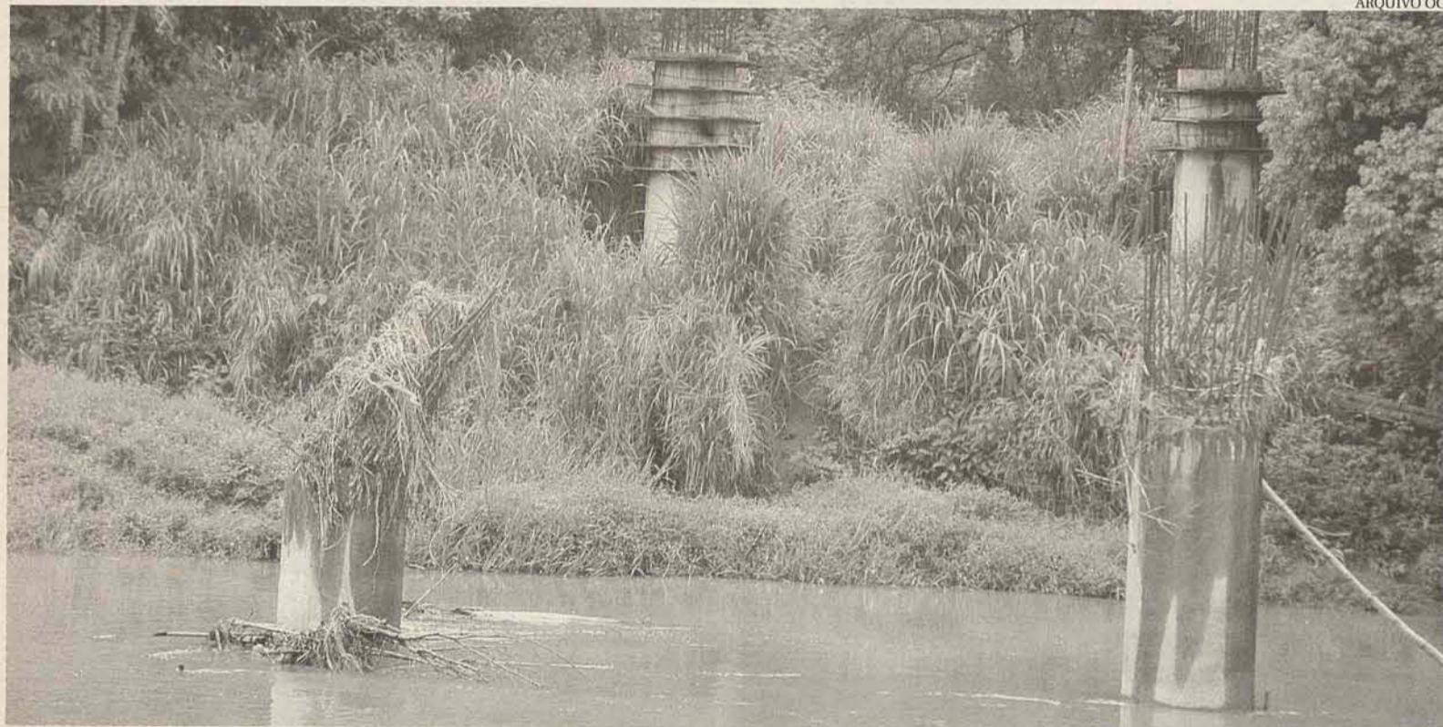
PRÓXIMO AO MERCADO RAU Pilares começaram a ser erguidos em 2008, mas obra foi abandonada
