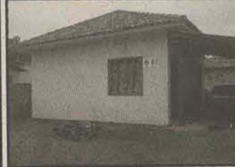
065 - Ribeirão Cavallo, casa de alvenaria c/ 37,82m² e terreno c/337,50m². (aceita financiamento bancário). R$ 108.000,00
