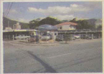
VENDE CENTRO Excelente Terreno com área de 1.240m². Ótimo para Construção de Prédio
