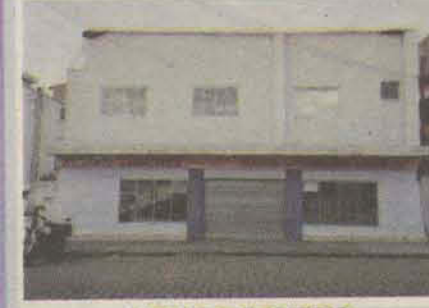
VENDE CENTRO Oportunidade de Investimento no Centro da Cidade. Terreno com área total de 688 m².
