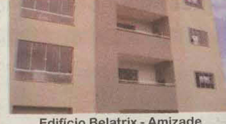
Edifício Belatrix - Amizade Ap NOVO 1 suíte + 2 quartos, garagem sacada c/ churrasq. R$ 175.000,00.
