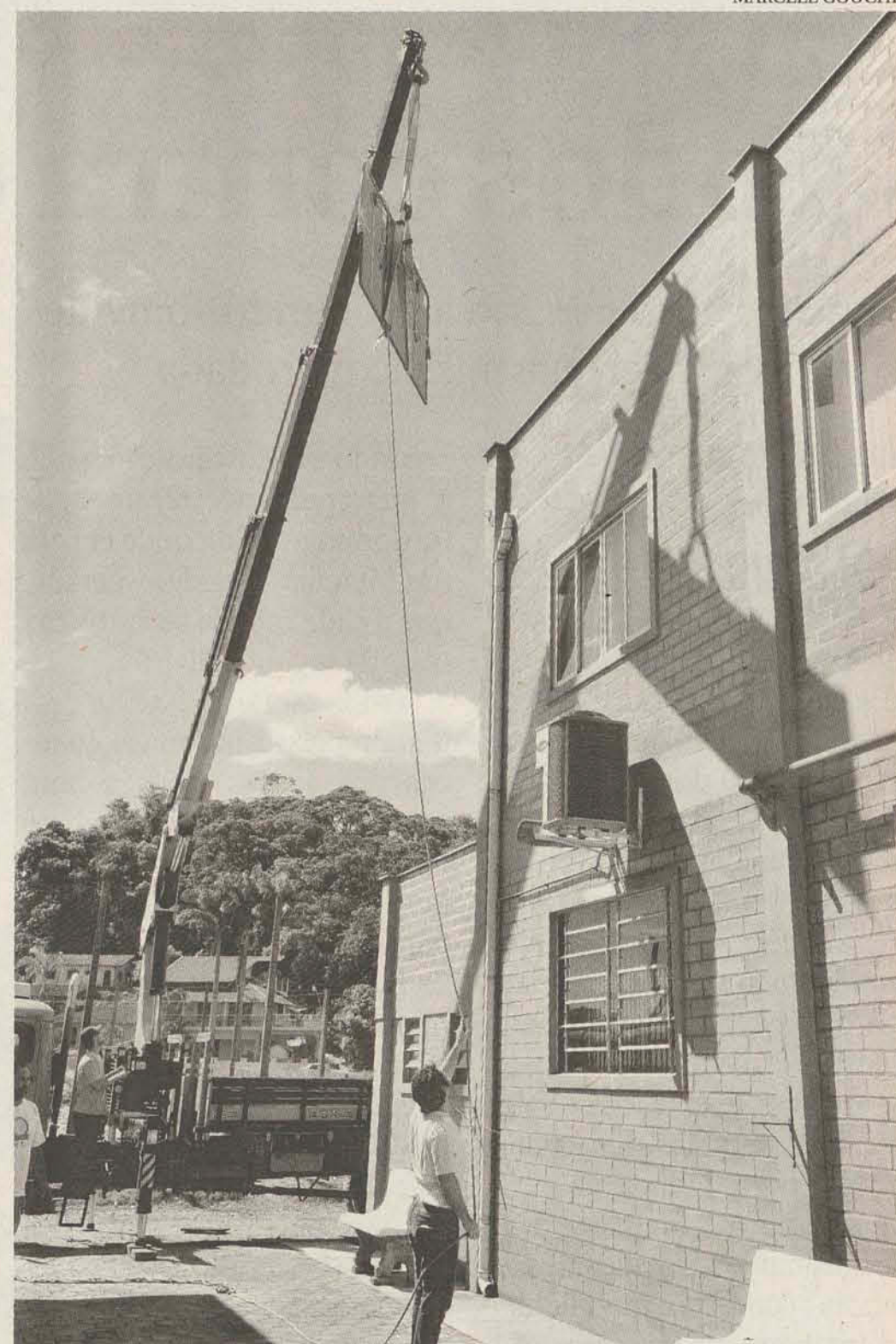
INOVAÇÃO Painéis solares para fornecimento de energia do JaraguaTec foram instalados ontem
