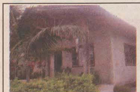
Cód 101 - CASA ALVENARIA, Estrada Nova, com área de 140m², 4 dormitórios, 2 vagas de gar. Terreno c/ 406m². R$ 180.000,00
