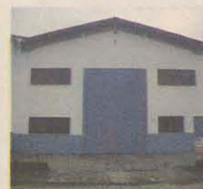
•Ref. E-48 - Vila Lalau •Galpão com aprox. 270 m² •R$ 3.000,00
