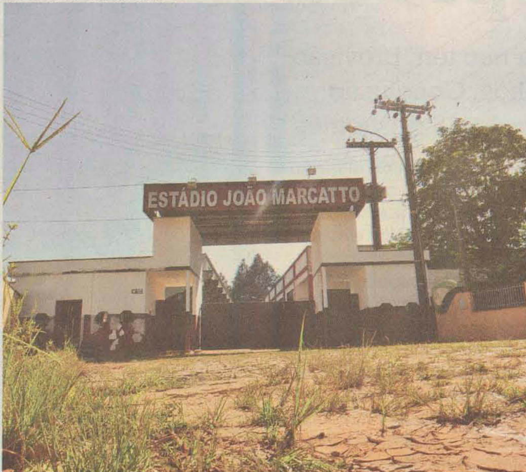
PROBLEMA Rua Mathias José Martins fica alagada durante as enxurradas
