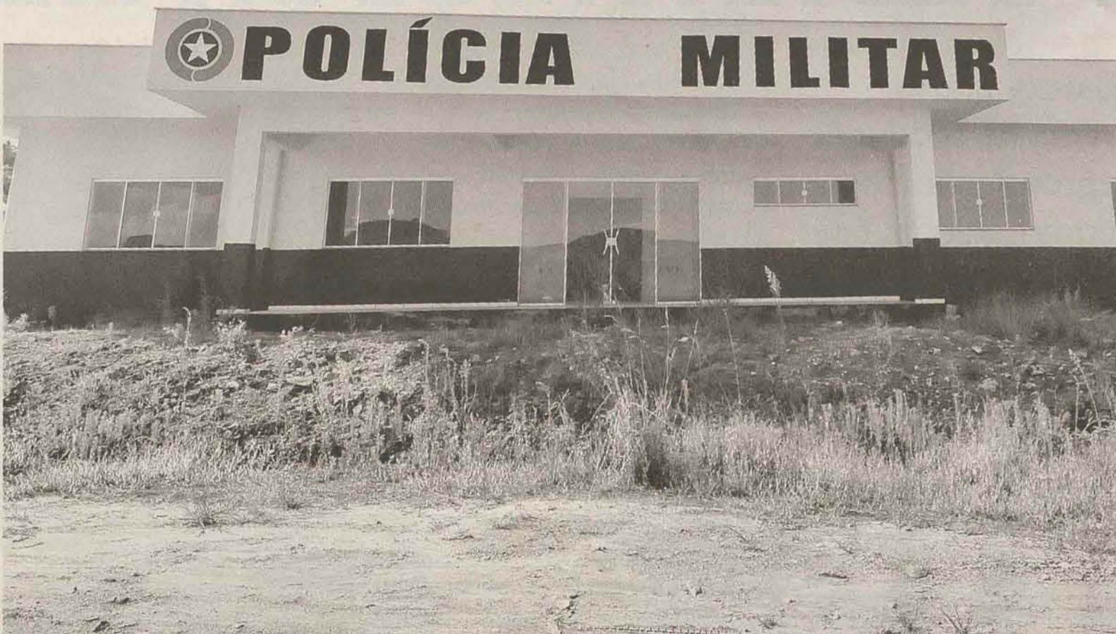
CRONOGRAMA Nova sede, edificada na rua 28 de Agosto, no Centro, já deveria estar pronta
