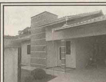
021 - Ribeirão Cavallo , casa de alvenaria com 162,30m² e terreno com 364,66m². R$175.000,00
