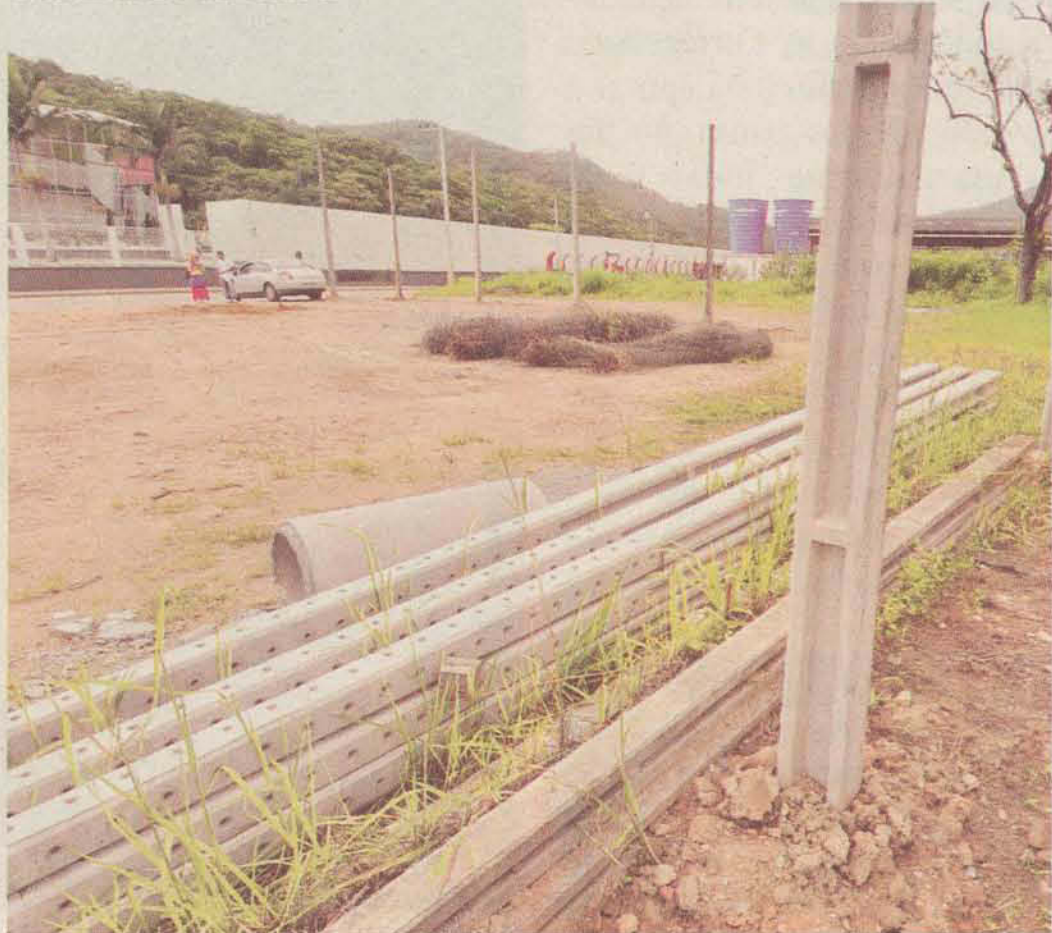
LAZER Local destinado à área de lazer está à espera de obras de terraplanagem, tubulação, parquinho e alambrado
