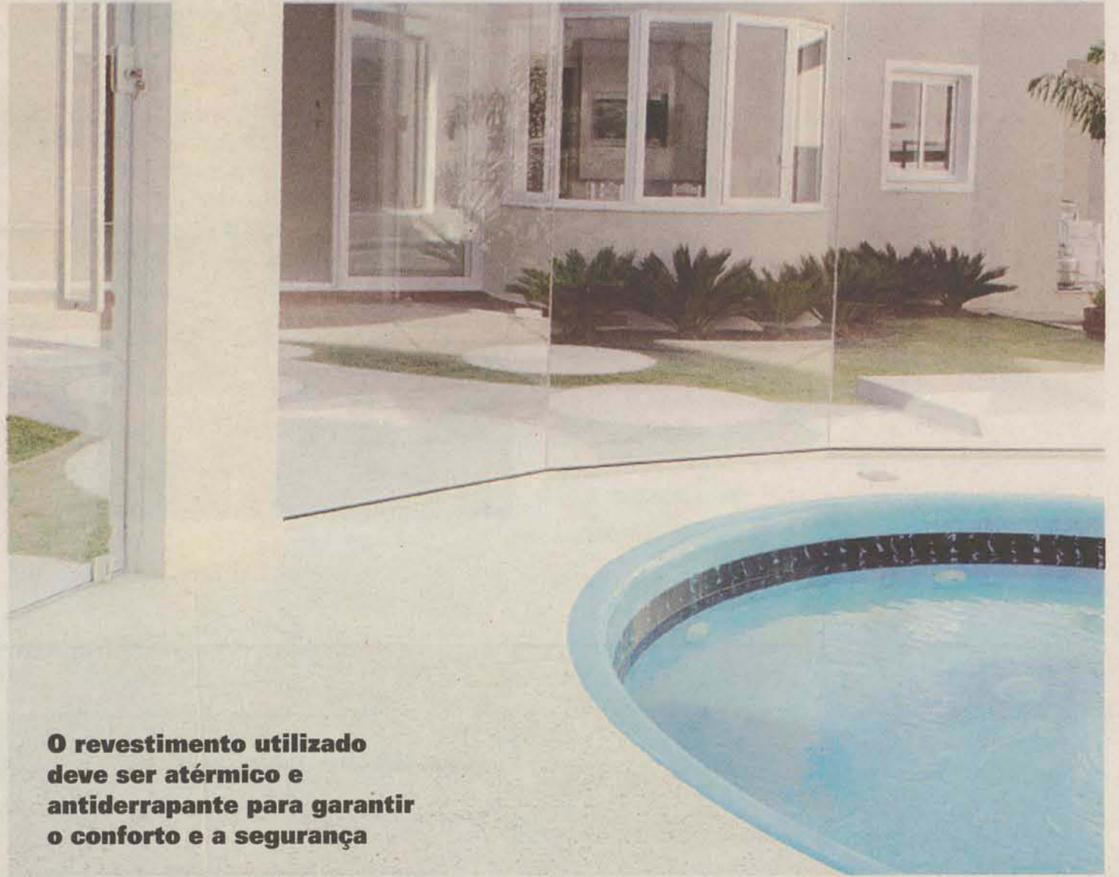
O revestimento utilizado deve ser atérmico e antiderrapante para garantir o conforto e a segurança
