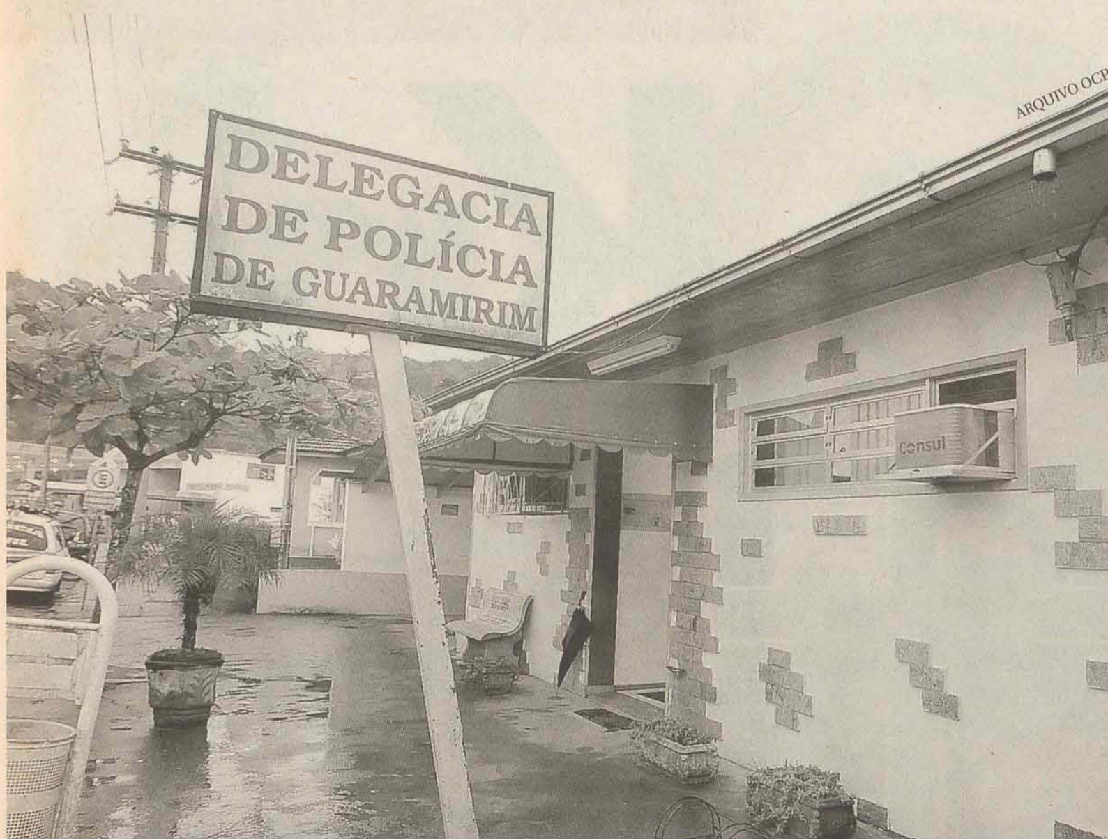
SEM CONDIÇÕES Prédio onde atualmente funciona a DP foi construído há mais de 60 anos
