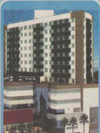
Ref: 0331 - Resid. Jaraguá Tower - Centro Apto em construção com Suíte + 2 dorm, Área útil 114m² R$ 350.000,00 R.I nº: 61.952
