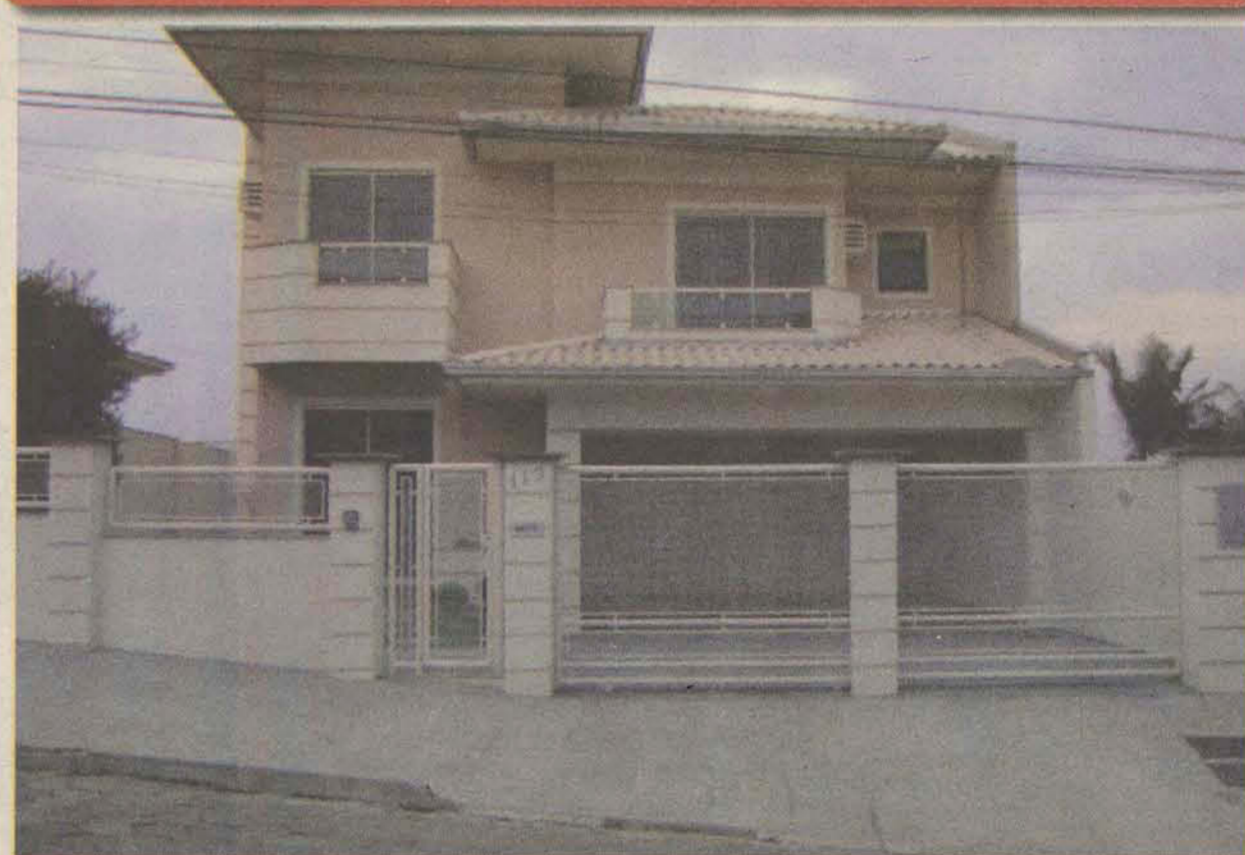
Ref. 569.1 - Excelente Casa na Ilha da Figueira com 1 suíte + 2 quartos, 2 salas, cozinha, área de festa interna, lavanderia, área de festa externa com piscina e deck, garagem para 4 carros. R$580.000,00
